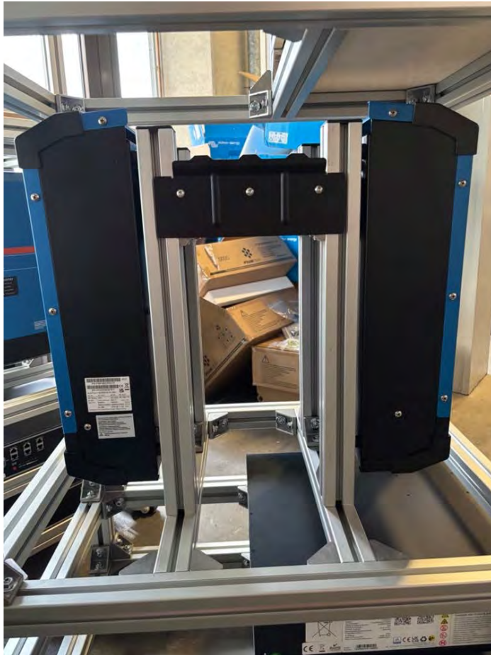
Abb. 3-11: Montage der Wechselrichter mit vormontierter Trägerstruktur und Victron-Wandhalterungen.
