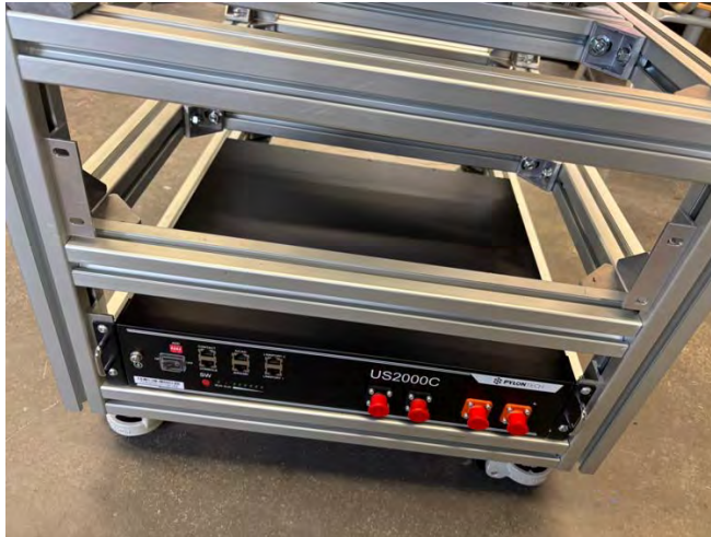
Abb. 3-14: Montage der Pylontech-Batterien auf unterster Ebene.
