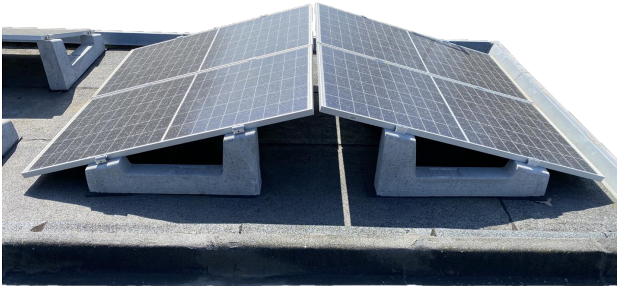
Abbildung 3: Ballastmodule [24]
