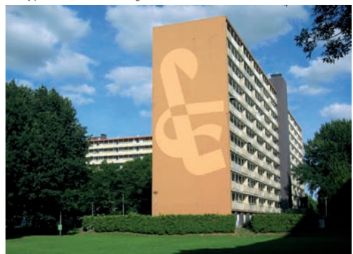
d) Typ G: Hochhausssiedlung
